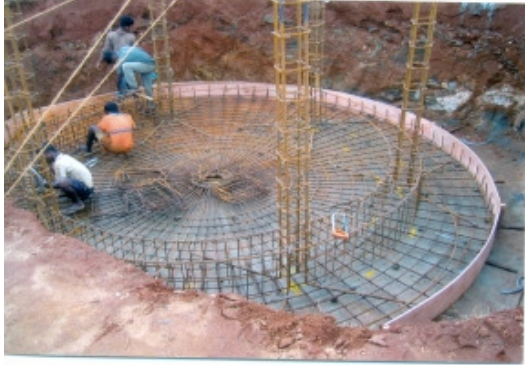
水塔施工情形
