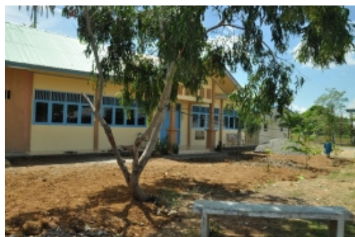
女生宿舍外部
